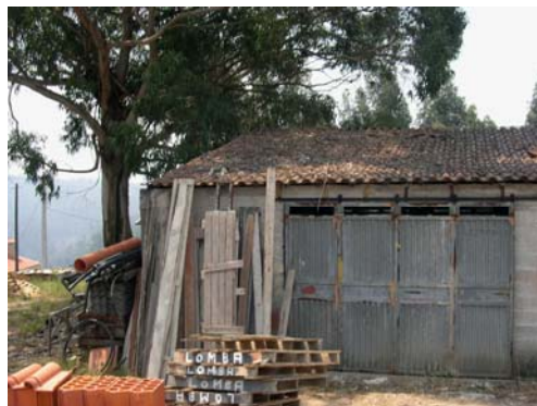
Figura 13 — Acumulação de material combustível junto à edificação.
