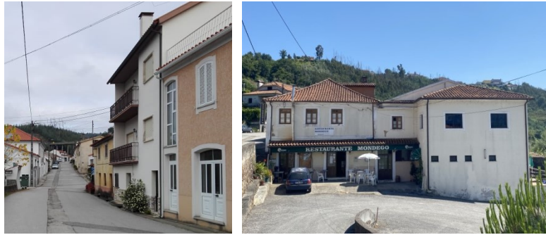
Figuras 18 e 19 – Edificado na ARU-PR – anomalias de Nível 3 (edifícios 025 e 035, identificados no Anexo I).
