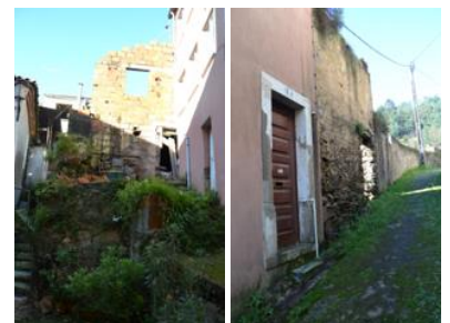
Figuras 17 e 18 – Edifício 88
