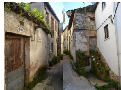
Figuras 46 e 47 – Edifício 132 e 133
