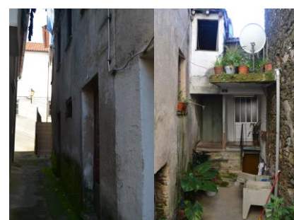
Figuras 48 e 49 – Edifício 138
