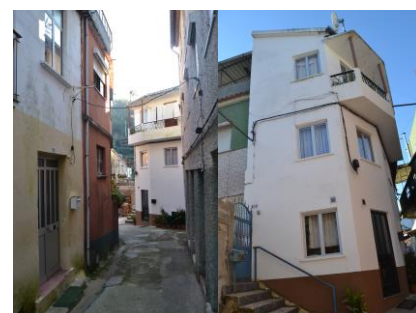
Figuras 94 e 95 – Edifício 157
