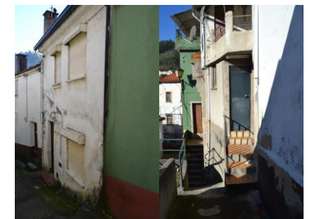
Figuras 39 e 40 – Edifício 103
