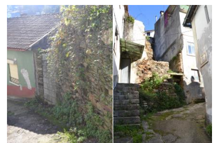
Figuras 33 e 34 – Edifício 101
