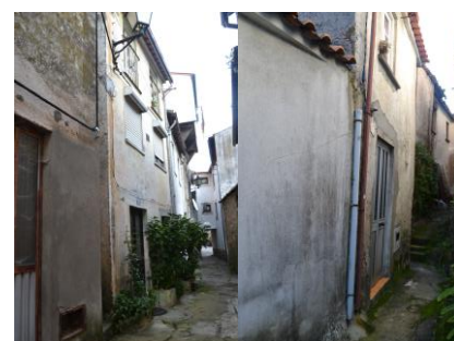
Figuras 79 e 80 – Edifício 143
