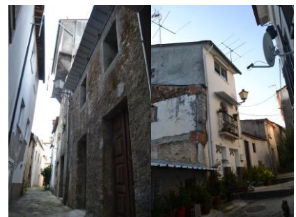
Figuras 83 e 84 – Edifício 145
