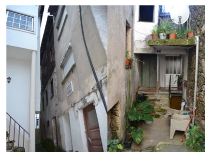
Figuras 50 e 51 – Edifício 139
