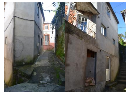
Figuras 62 e 63 – Edifício 118
