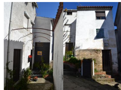
Figuras 64 e 65 – Edifício 126
