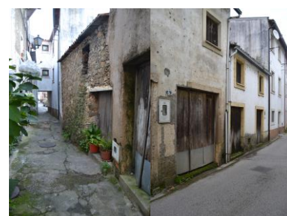
Figuras 75 e 76 – Edifício 53
