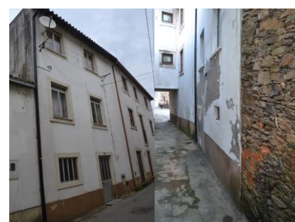
Figuras 77 e 78 – Edifício 54
