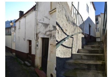
Figuras 41 e 42 – Edifício 104
