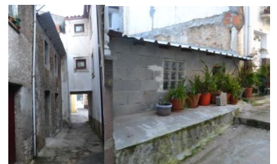
Figuras 85 e 86 – Edifício 146
