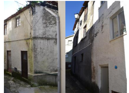
Figuras 56 e 57 – Edifício 114 e 115
