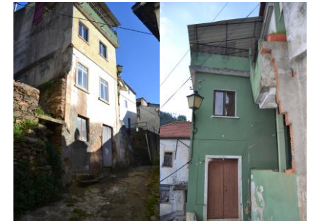
Figuras 36, 37 e 38 – Edifício 102
