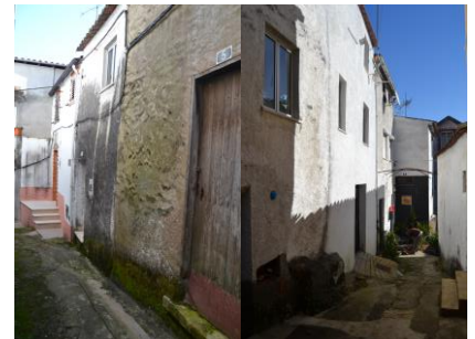
Figuras 58 e 59 – Edifício 116
