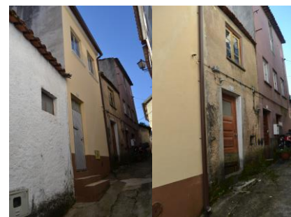
Figuras 68 e 69 – Edifício 128 e 129
