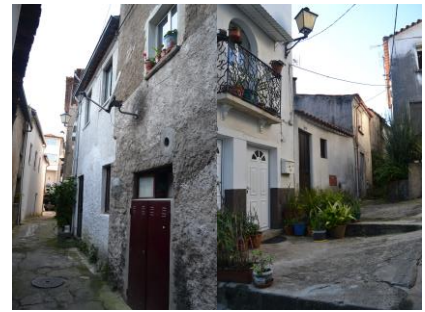
Figuras 81 e 82 – Edifício 144
