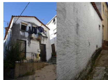
Figuras 66 e 67 – Edifício 127
