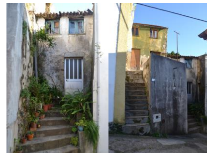
Figuras 100 e 101 – Edifícios 174 e 175
