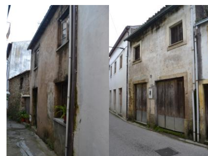
Figuras 73 e 74 – Edifício 52
