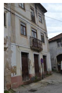
Figuras 28, 29 e 30 – Edifícios 36, 37 e 38
