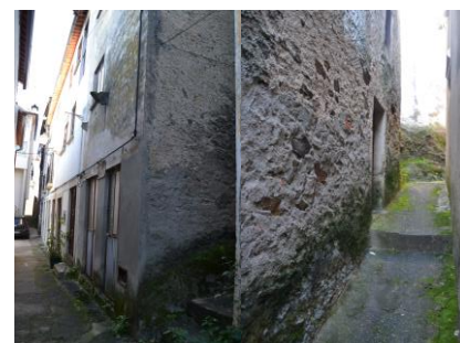
Figuras 52 e 53 – Edifício 142
