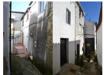
Figuras 60 e 61 – Edifício 117
